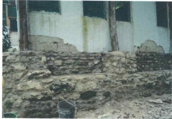
*Proceso de rehabilitación de cocina y comedor, en donde fue necesario recalzar y estabilizar la base sustentación de la construcción con piedra para estabilizar los muros existentes.*
